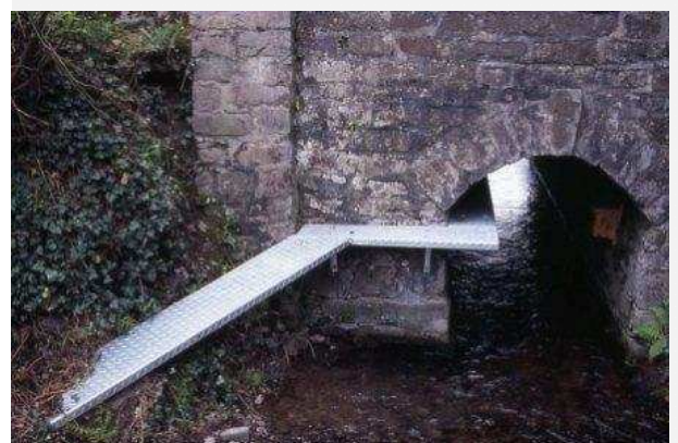
Fig. 29. Misure di prevenzione della mortalità sulla rete stradale. Da sinistra verso destra: (a) uso di recinzioni e tunnel per evitare il passaggio delle lontre su strade trafficate (per gentile concessione di Tim Bernhard); (b) Passaggio per lontre sotto ad un ponte, in Galles in Wales, UK (per gentile concessione di Geoff Liles). Per ulteriori immagini/video si veda:
